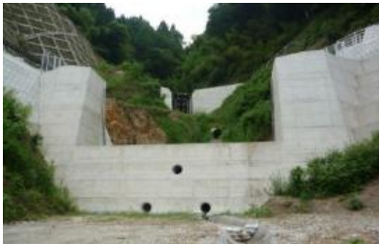
コンクリート巨大物が緑化され景観に配慮した物に生まれ変わる
