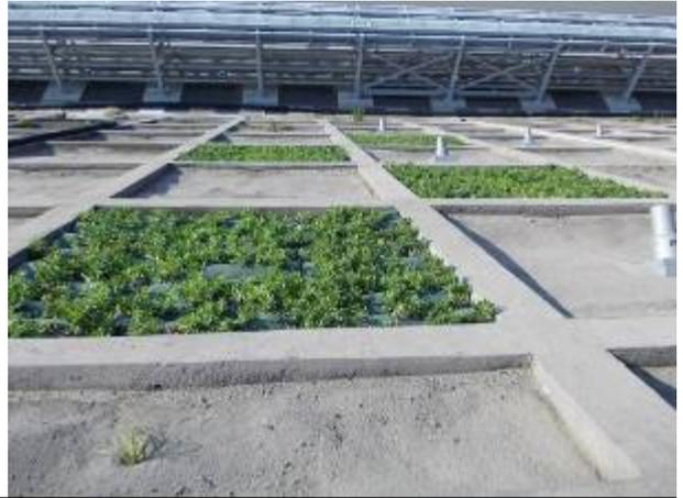
島根コンクリート法枠 常緑キリンソウ袋方式 面積：6330㎡(施工枠内数量) 施工：平成23年4月～5月中
