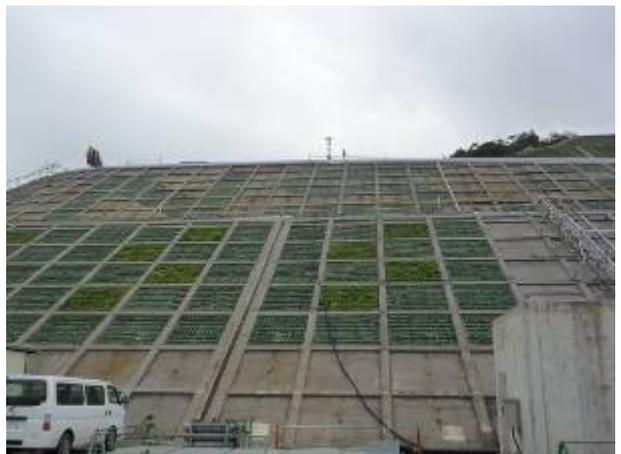
島根コンクリート法枠 常緑キリンソウ袋方式 追加工事 施工：平成23年8月～10月
