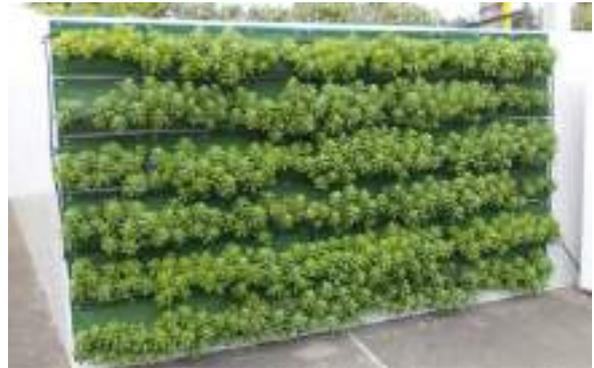
常緑キリンソウ袋方式®の壁面緑化用にはハトメが付いています。このハトメを利用し、アンカーボルトで壁面に固定します。
