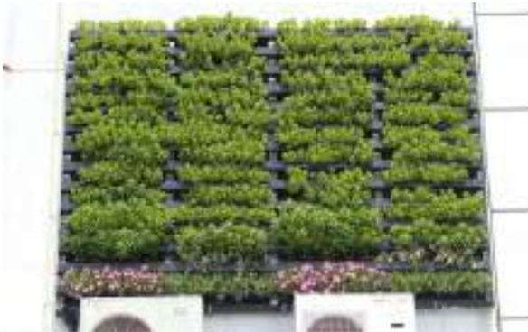
建築工事で用意されたアルミ製の枠の中に、常緑キリンソウ袋方式®を入れて壁面緑化を行いました。アルミ枠は別途建築工事となります。
