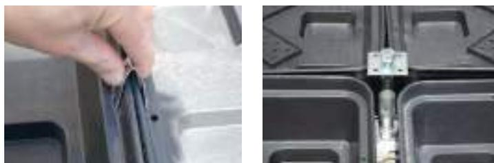
一般的な屋上緑化システムの施工例。防水改修の際に障害となる施工方法が採用されている。
