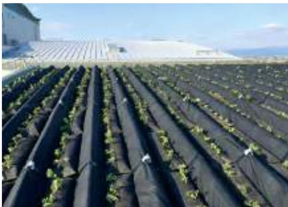
折板全体に防草シートを敷設し、谷部分に常緑キリンソウを並べています。袋同士は長手方向で連結し、端部はチェーンと連結しています。
